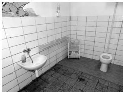
Umývárna před rekonstrukcí
