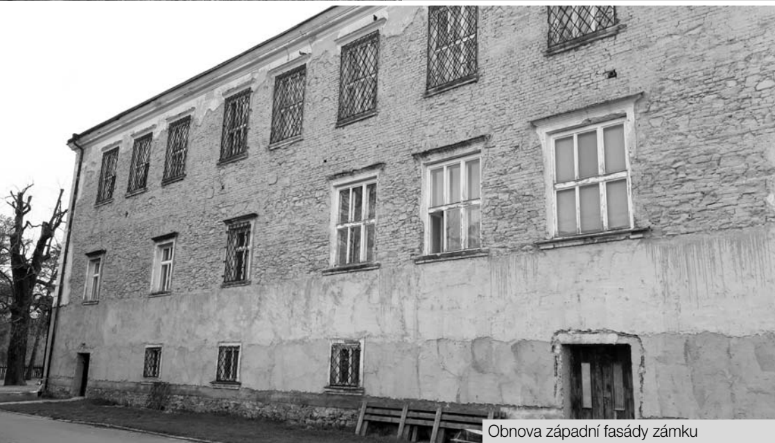
Rekonstrukce chodníku Zámecká-Mlýnská
